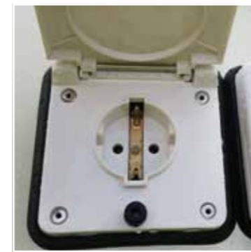
Prise électrique 230V - extérieure (avec convertisseur 2000W et câblage batterie)
