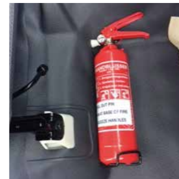
Extincteur 1 kg, installé
